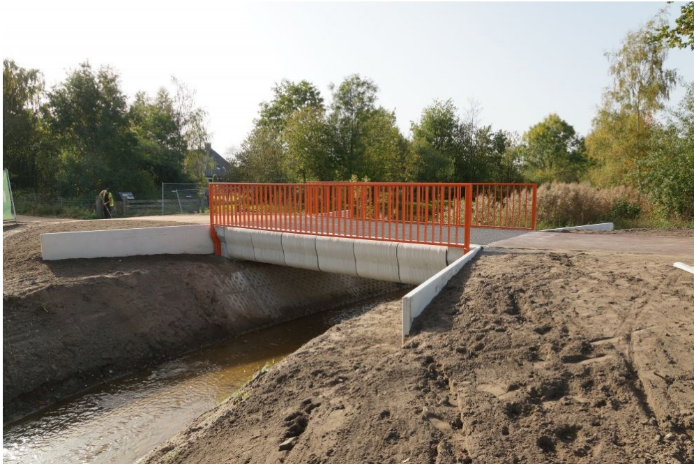
Eerste 3D geprinte brug ter wereld in Gemert.
